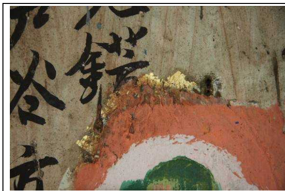
二荒山神社本殿東妻入破風束の金箔痕跡
