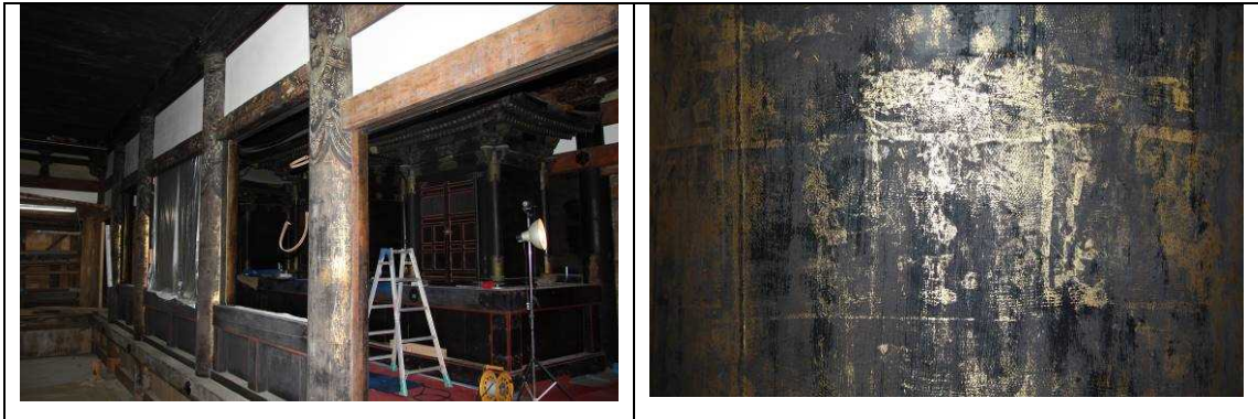
写真 19: (参考資料)清水寺観音堂における内陣四天柱の寛永期金箔の箔足
