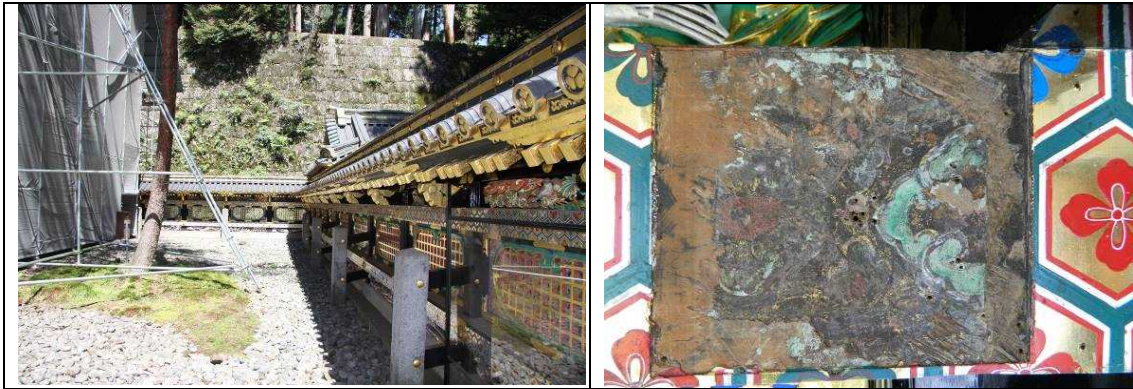
写真 32: 日光東照宮透塀の現状
