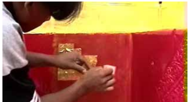
8 仏塔に箔押しする箔打師 錆止め塗料、油性塗料を塗ってから箔を押し、脱脂綿で軽く押さえる (チェンマイ)
