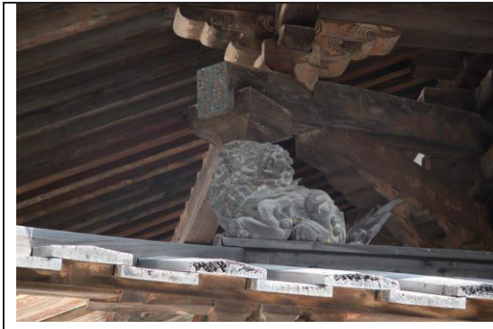
写真 5:法隆寺金堂向肘木木口面の鍍金金具
