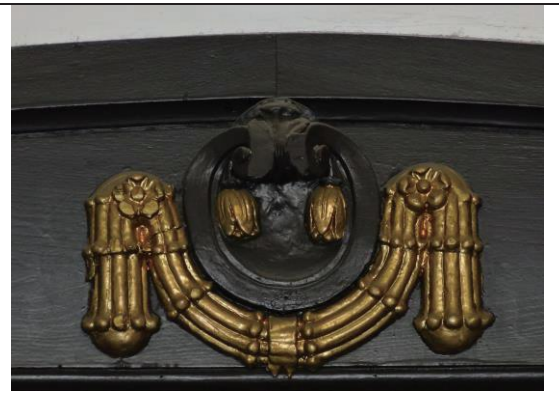
写真 13:洋館内(横浜市)の飾金具における金箔使用状況
