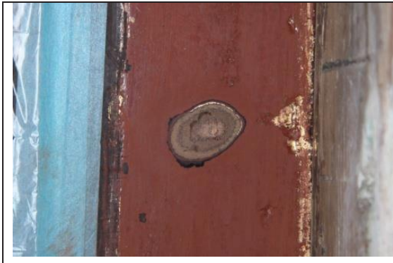
写真 20-1: 日光東照宮本殿背面方立板における塗装来歴痕跡と寛永期金箔 写真 20-2: 同 寛永期金箔の拡大(試料 2)
