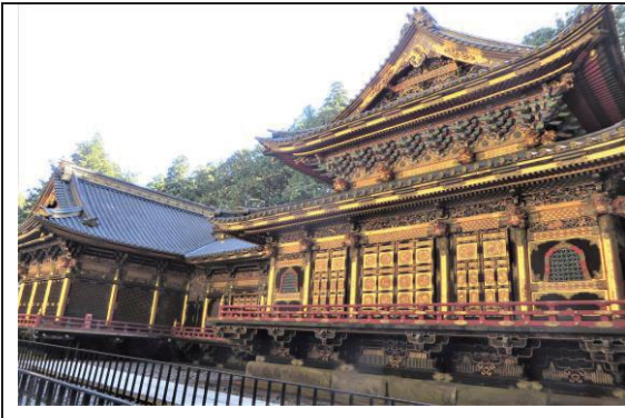
写真 10:日光山輪王寺大猷院霊廟本殿・石の間・拝殿の現況
